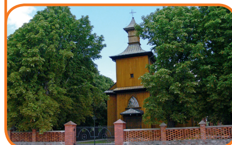
Fot. arch. Urzędu Gminy Czerwińsk nad Wisłą
